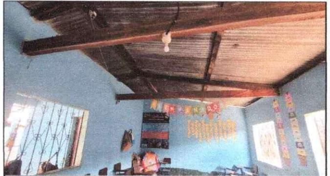
**Foto 2:** Se cambiaran las vijas y costaneras a metal por el deterioro de la madera.
