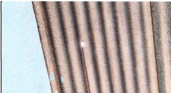
**Foto 3:** Se cambiaran las laminas antiguas por deterioro y perforaciones.
